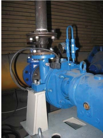
شکل ۳۲- محل قرارگیری ترانسدیوسر فشار
