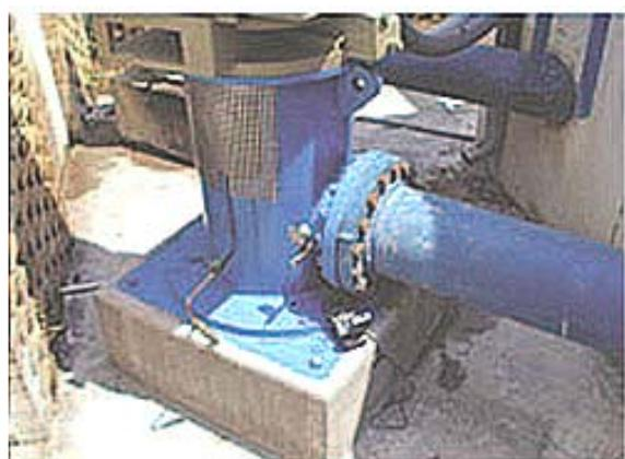
شکل ۱: پمپ عمودی توربینی
